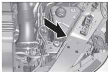
Ubicación de cubierta de protección
